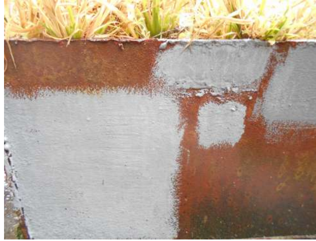
鉄製の花壇 錆の上から塗装
