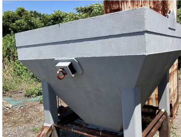
【防錆剤塗装直後】
