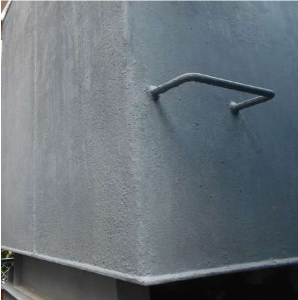
【機械ケレン処理】
