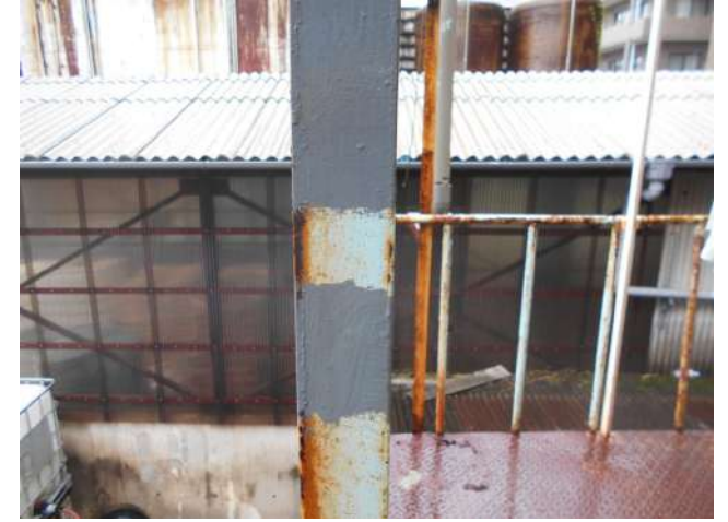
鉄製の柱 下地の塗装の上から塗装
