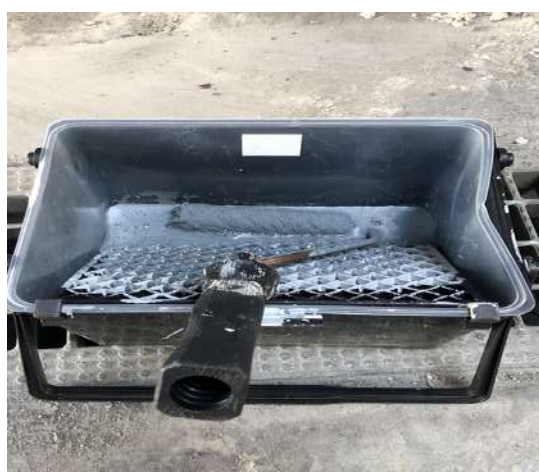
5 容器に移しローラーに染み込ませる
