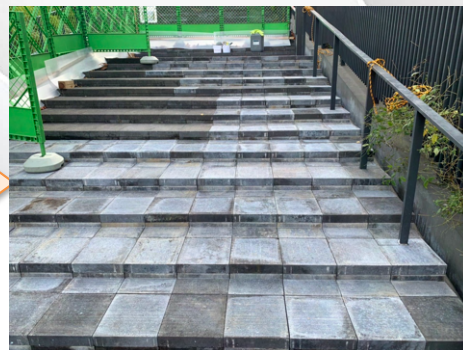
② NOROCON Motar (エフロ除去) により白華部分を洗浄、除去
