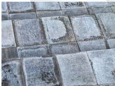
① エフロが発生した階段の表面
