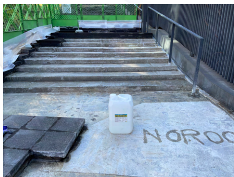
⑤ 躯体の保護と汚れ等の浸透防止の為、NOROCON Coat剤を塗膜する。
