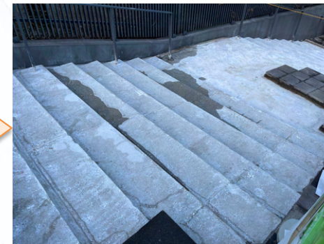
④ 躯体部分をケレンと洗浄を併用し、露出させて乾燥させる。
